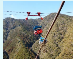
架線集材作業の自動化
