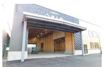
大盤パネルを用い大空間を実現した取組例 二ヘイ札幌配送センター（石狩市）
