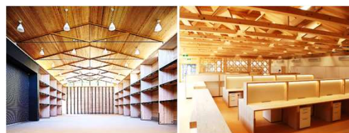
CLTを活用した設計・建築等の実証
